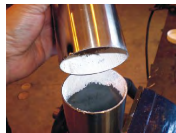
Aplicação no interior da união a soldar
